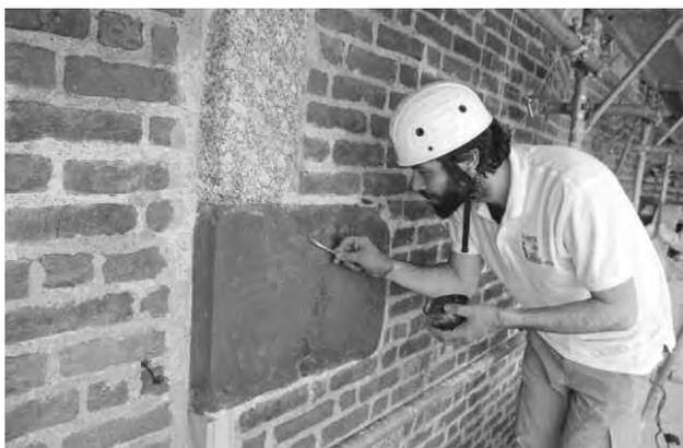
mentre sono state eseguite iniezioni di biocida localizzate per eliminare le piante di fico presenti.
