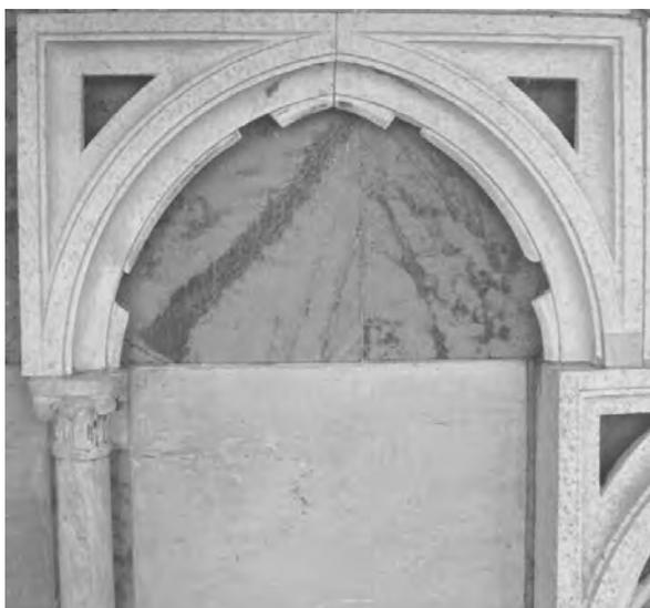
possedere doti di resistenza agli attacchi delle piogge acide, maggiore di quella del carbonato di calcio, principale costituente delle pietre originarie. Questo trattamento inoltre non patisce le alterazioni tipiche dei materiali di origine sintetica, in quanto di natura minerale e di estrema compatibilità fisico-chimica con i materiali originali.
