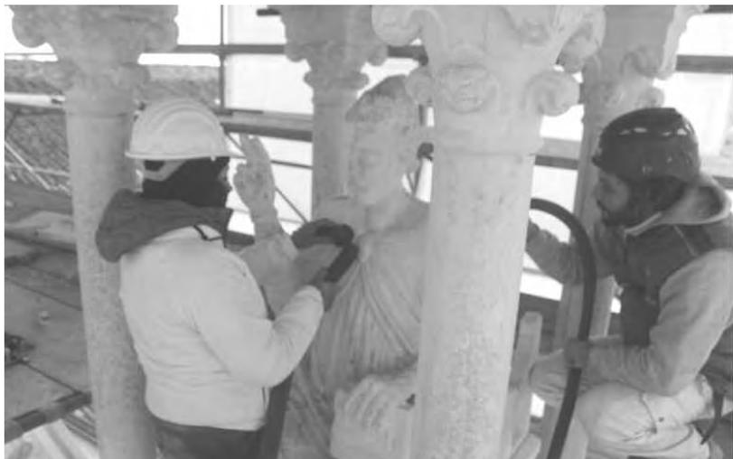
spigoli dei blocchi sono oramai smussati e la porosità del materiale è profondamente aumentata. Per rallentare questo processo di invecchiamento della pietra è stato messo a punto un metodo basato sul consolidamento mediante impregnazione ad impacco di una soluzione minerale a base di ossalato di ammonio che rinforza la pietra nelle porzioni più decoese e forma una superficie di sacrificio, con la caratteristica di
